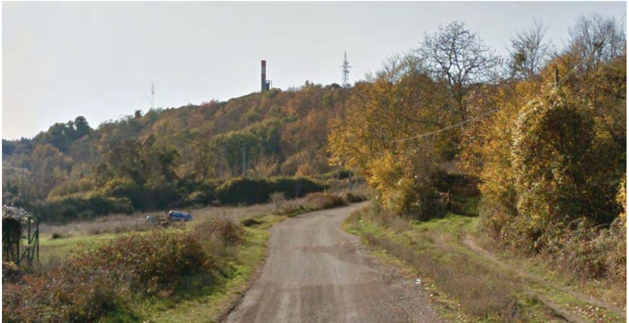
Figura 95 - Vista attuale del camino della centrale "Latera" dalla strada secondaria di accesso all'area di centrale
