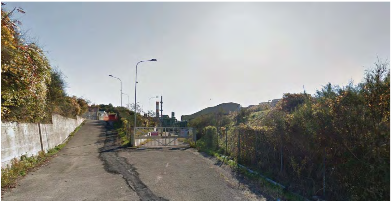
Figura 98 - Vista post intervento del camino della centrale "Latera" dall'ingresso all'area di centrale
