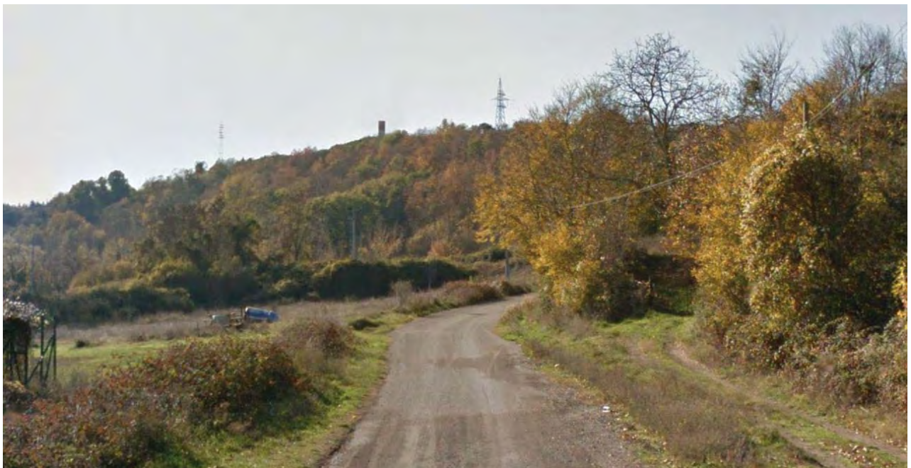
Figura 96 - Vista post intervento del camino della centrale "Nuova Latera" dalla strada secondaria di accesso all'area di centrale
